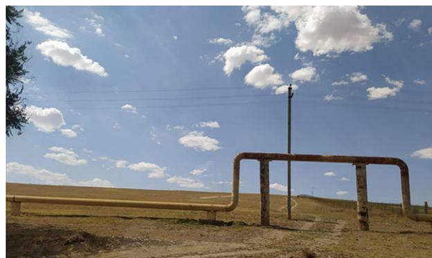
Газопровод и линия ЛЭП-10кВ пересекающие ось предполагаемого трубопровода
