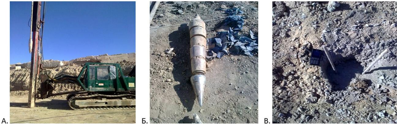
Рисунок 1 – Устройство свай в раскатанных скважинах в г. Шымкенте по ул. Байдибек-би
