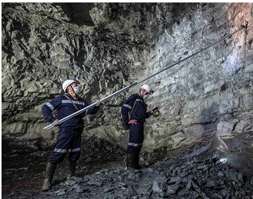
Рисунок 1 – Процесс РФО забоя с аппаратурой РПП-12
