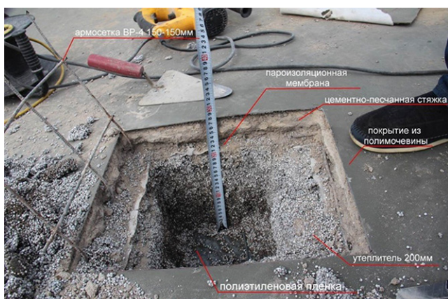
Рисунок 4 – Общий вид контрольных вскрытий мягкой кровли на выборочных участках
