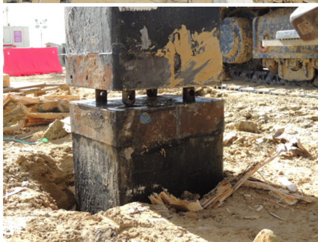
Рисунок 1 – Установка составных железобетонных свай
