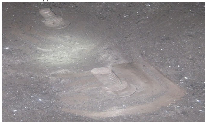
а – Қарағанды көмір бассейнінің «Шахтинск» шақтысында табан жыныстарды қарнақтармен бекіту; б – тәптіштеу
