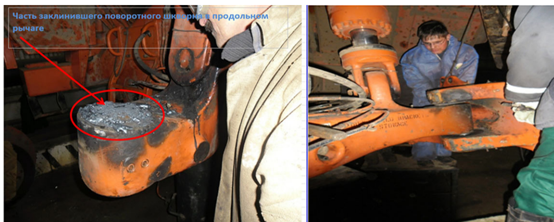
Рисунок 6 – Ремонтные работы автосамосвалов на карьерах РК
