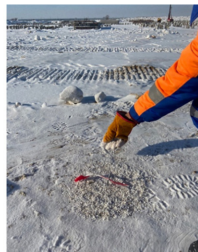
Рисунок 1 – Фрагмент засыпки химического реагента с использованием негашеной извести и измерением глубины оттаивания
