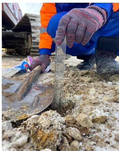
Рисунок 1 – Фрагмент засыпки химического реагента с использованием негашеной извести и измерением глубины оттаивания
