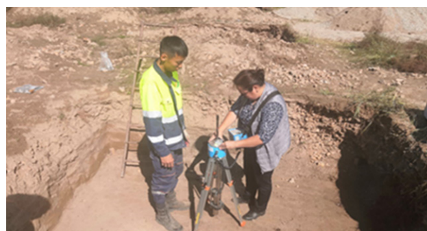
Рисунок 7 – Испытание уплотняемости грунта подушки
