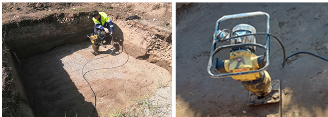
Рисунок 4 – Послойное уплотнение грунта основания машиной BS 60-2
