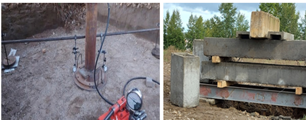
Рисунок 6 – Проведение штамповых испытаний
