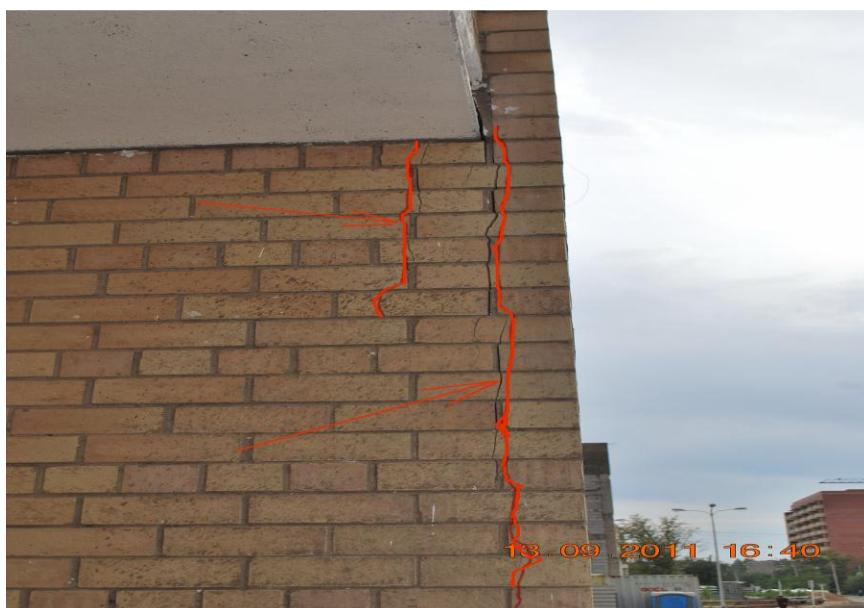
Рисунок 1 – Вертикальная трещина шириной раскрытия  $a_{cr}=2\dots6$  мм по кирпичу и раствору на высоту до 26 рядов в кладке пилестры в уровне 1-го этажа
