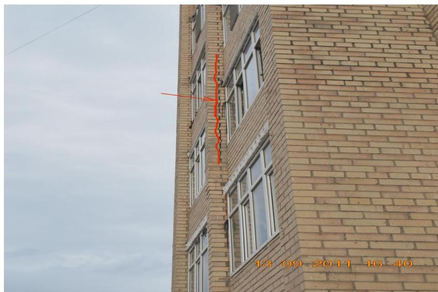
Рисунок 2 – Вертикальная трещина шириной раскрытия  $a_{crc}=0,7\dots5$  мм по кирпичу и раствору на высоту до 34 рядов в кладке балконной перегородки в уровне 3-го этажа
