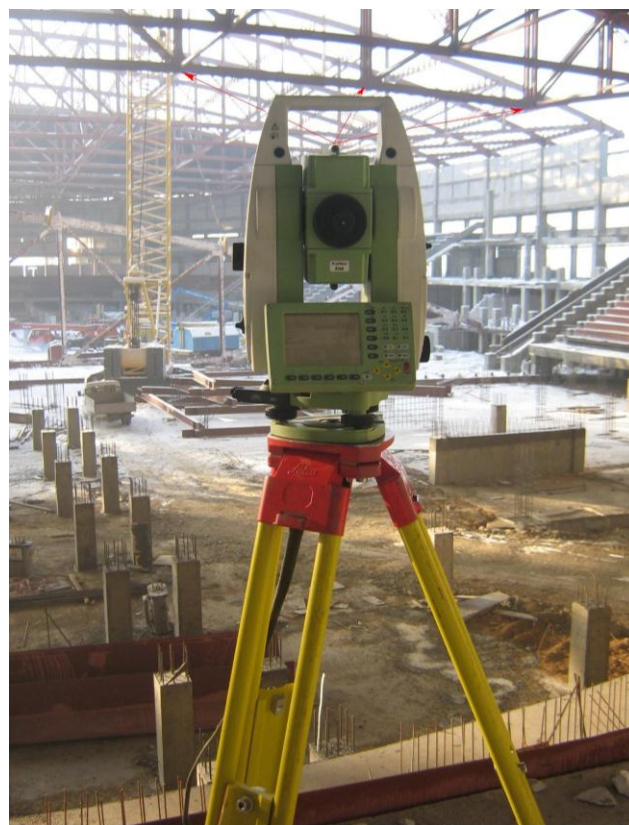
Рисунок 2 – Высокоточные измерения характерных точек узлов строительных конструкций электронным тахеометром TCR 1201 Leica
