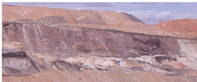
Рисунок 1 – Оползень борта разреза в районе р.л. А 4 и р.л. А 5
