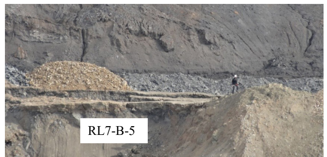
б – деформации в районе профильной линии RL7-B (5-й рабочий репер)
