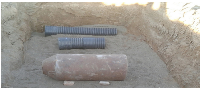
Рисунок 4 – Мишени на днище котлована
