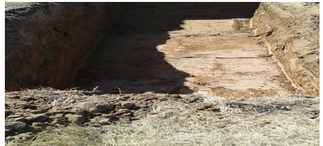
Рисунок 1 – Котлован (745/245/190). Почва стен и днище-суглинка
