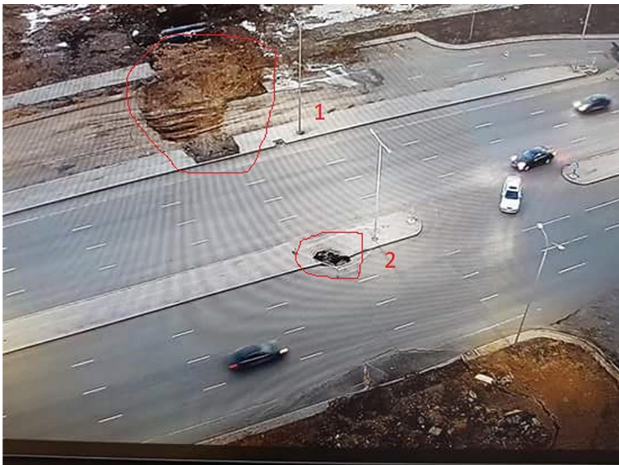
Рисунок 2 – Провалы в результате промерзания-оттаивания по г. Нур-Султан
